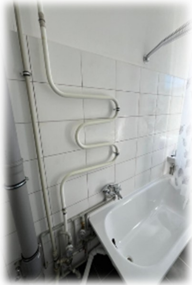
Jāņa Asara iela 15, Rīga, pirms un pēc remonta
